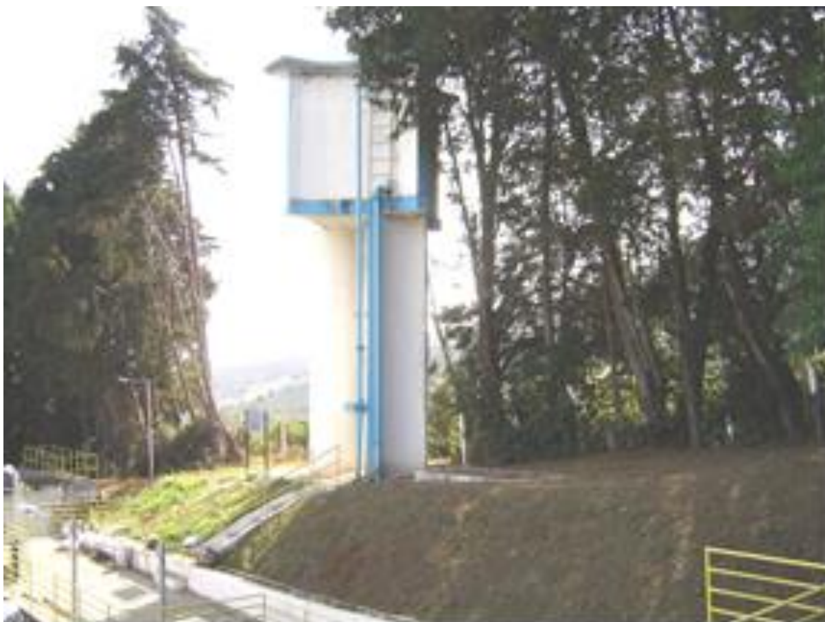
Figura 32: Vista do REL 3 com 25 m 3 da área da ETA
