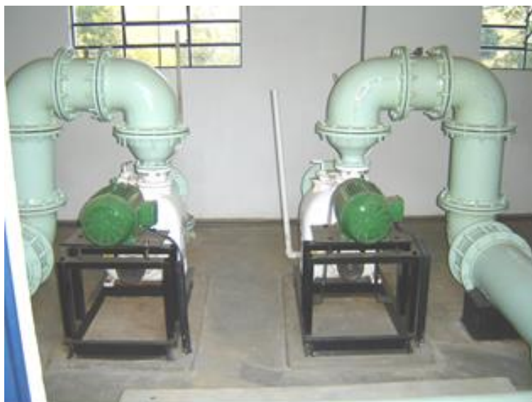
Figura 17: EAB de Baixo Recalque (Interna)
