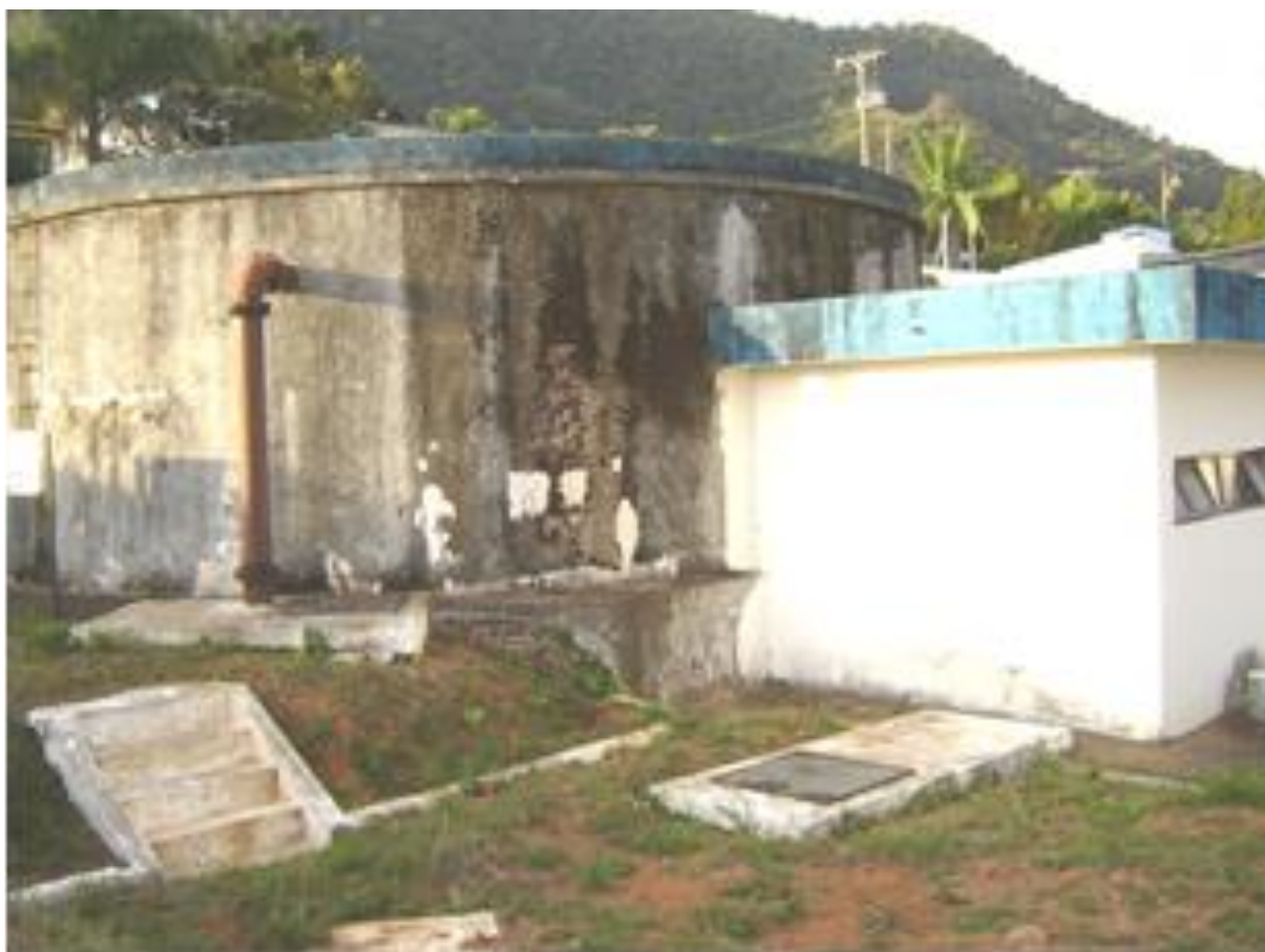
Figura 31: Vista do RAP 2 com 250 \text{ m}^3 e da EAT Zona Alta Fonte: COPASA (2006)
