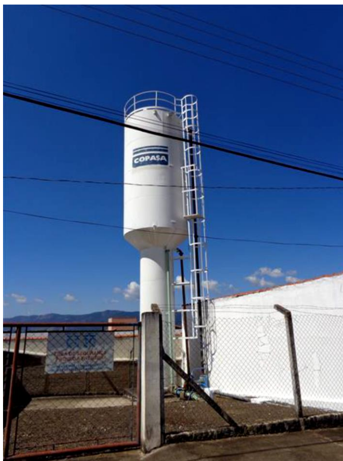
Figura 40: Vista do REL 10 com 50 m 3 no Jd. Alvorada Fonte: ARSAE (2019)
