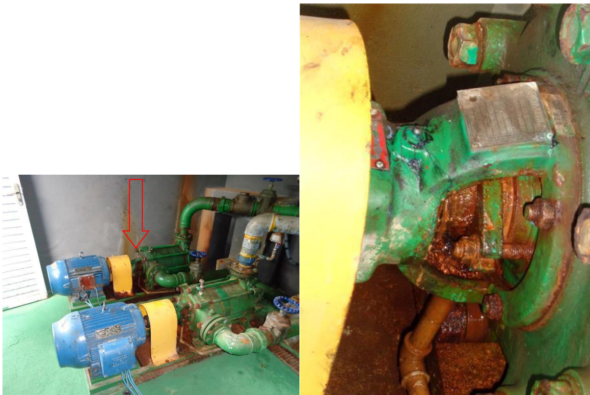
Figura 37: Detalhe dos conj. Motobomba do Booster Jardim Ipê, com excesso de vazamento na gaixeta da bomba
