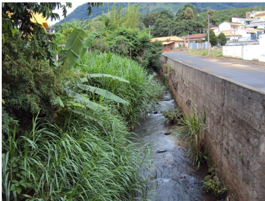
Figura 78: Retificação do Ribeirão do Caracol na Rua Leonardo Alves dos Santos privilegiando a via de tráfego
