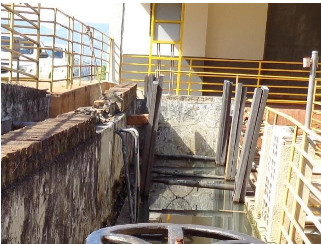
Figura 23: Detalhe para a parede do canal de chegada escorada e o tanque inundado Fonte: ARSAE (2019)
