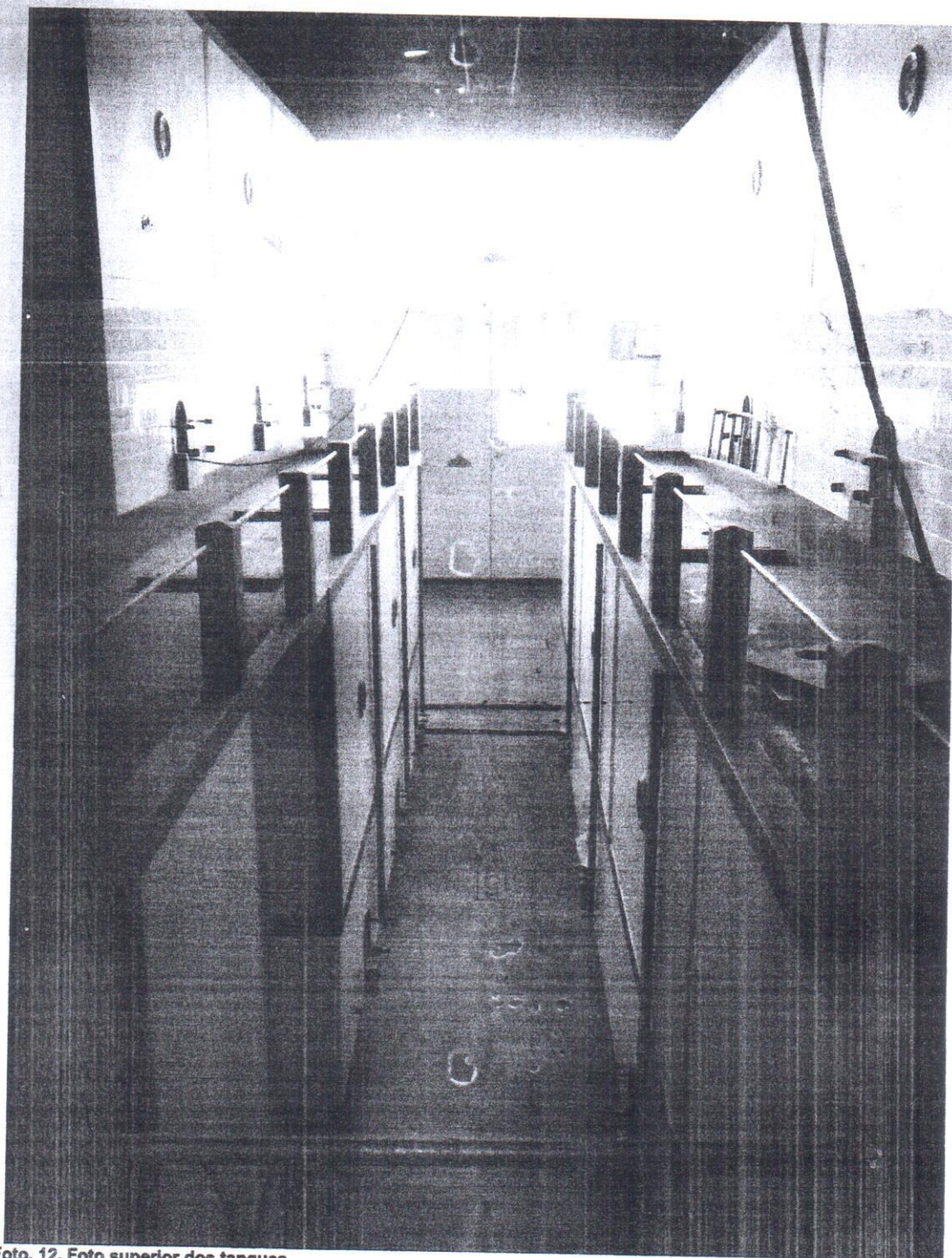
Foto. 12. Foto superior dos tanques Fonte: Tâmara C. Corsi – Data 20/06/2016
