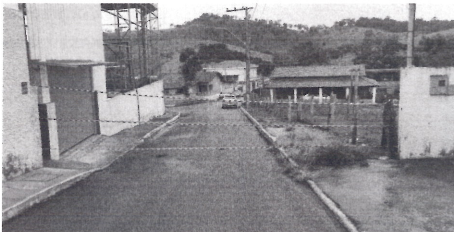
Imagem 05: Rua interditada ao entorno da Quadra Poliesportiva do Distrito do Campestrinho. – Arquivo da Divisão de Planejamento Urbano.
