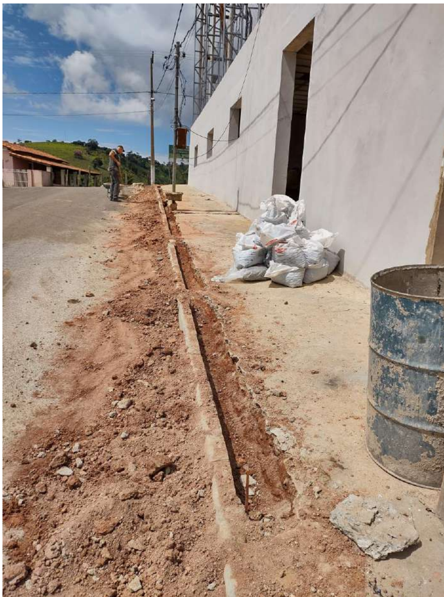
Imagem 03: Demolição de calçada realizada para instalação de parte do sistema SPDA da quadra. Arquivo da Divisão de Planejamento Urbano e Projetos.
