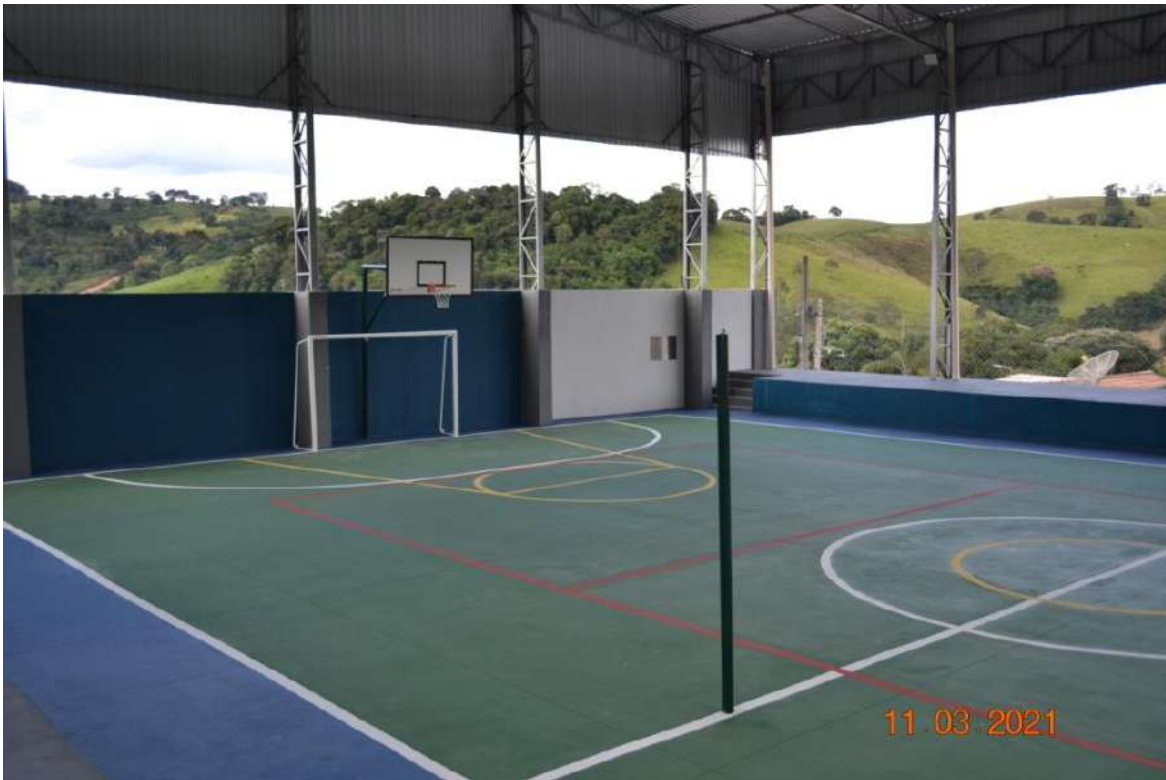
2 – Detalhe da pintura do piso
