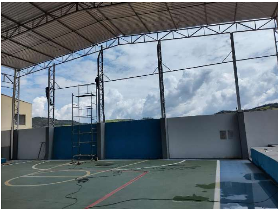
Imagem 06: Fechamento lateral em processo de execução. Arquivo da Divisão de Planejamento Urbano e Projetos.
