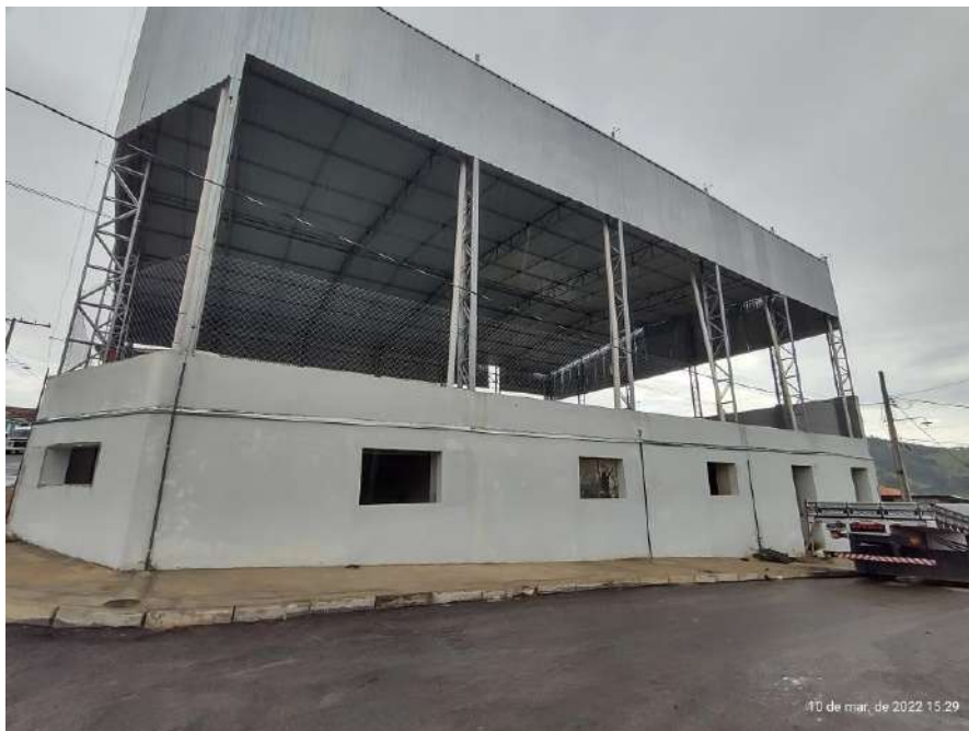
Imagem 01: Vista externa da Quadra Poliesportiva do Distrito do Campestrinho. Arquivo da Divisão de Planejamento Urbano e Projetos.
