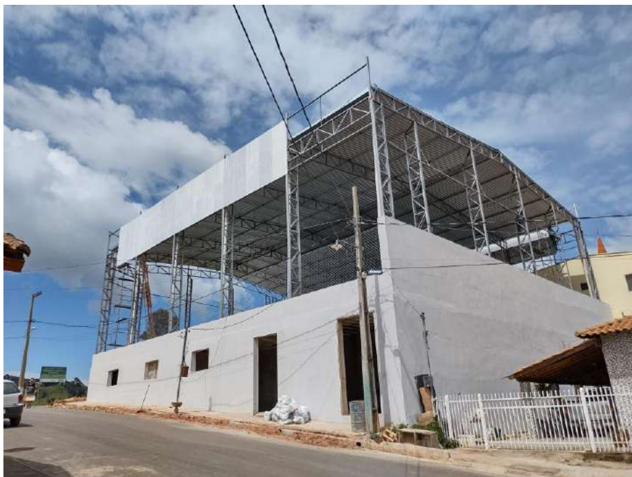
Imagem 01: Instalação de fechamento lateral na quadra poliesportiva do Distrito do Campestrinho. Arquivo da Divisão de Planejamento Urbano e Projetos.
