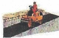
Quanto à compactação do PMF, promover somente 02 (duas) passadas na camada final para evitar a desagregação da massa.
