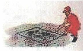
2- Recortar o revestimento a ser removido com a utilização de chibancas e picaretas.
