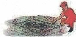
2- Recortar o revestimento a ser removido conforme a área escolhida, com o auxílio de equipamento mecânico, martelete pneumático ou serra clipper preferencialmente. A utilização de chibancas e picaretas só é recomendável quando o pavimento tiver espessura inferior a 5 cm.
