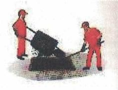
8- Espalhar pouca água sobre toda a camada final da massa, utilizando-se de um regador. Não pode ocorrer formação de poças. O objetivo é facilitar o deslizamento do compactador sobre a massa e proporcionar um acabamento liso quando da operação de compactação final.
