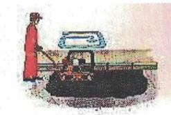
No caso de trechos de comprimento superior a 20 metros e 3 metros de largura, é recomendável a utilização de compactador de maior potência, tipo CC800, ou equivalente.
