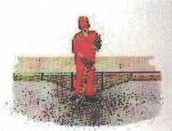
2- Executar a pintura de ligação na área afetada, utilizando emulsão asfáltica tipo RR -1C, pura, ou diluída no máximo com 20% (vinte por cento) de água a critério da fiscalização. A emulsão deve cobrir toda a área que vai receber a massa asfáltica, sem se acumular em poças. Deve-se estender a pintura de ligação por 10 a 20 cm além da área afetada, isto é, para cada lado do abatimento.
