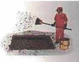
6- Preencher o local com CBUQ Faixa C, na temperatura entre 110°C e 177°C, ou PMF de graduação densa na temperatura ambiente. O preenchimento deve ser cuidadoso e ser iniciado 5 (cinco) minutos após a execução da pintura de ligação, devido à necessidade de ruptura da emulsão asfáltica. Com a utilização de rastelo
